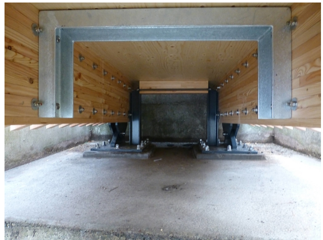
Die neue Brücke wurde in die vorhandene Abutmentnische eingeklemmt
