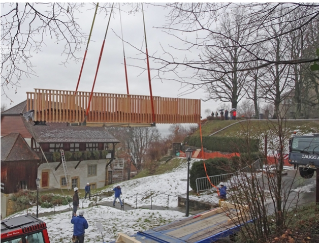
Ein Kran hob die 10,5 Meter lange Brücke an die richtige Stelle
