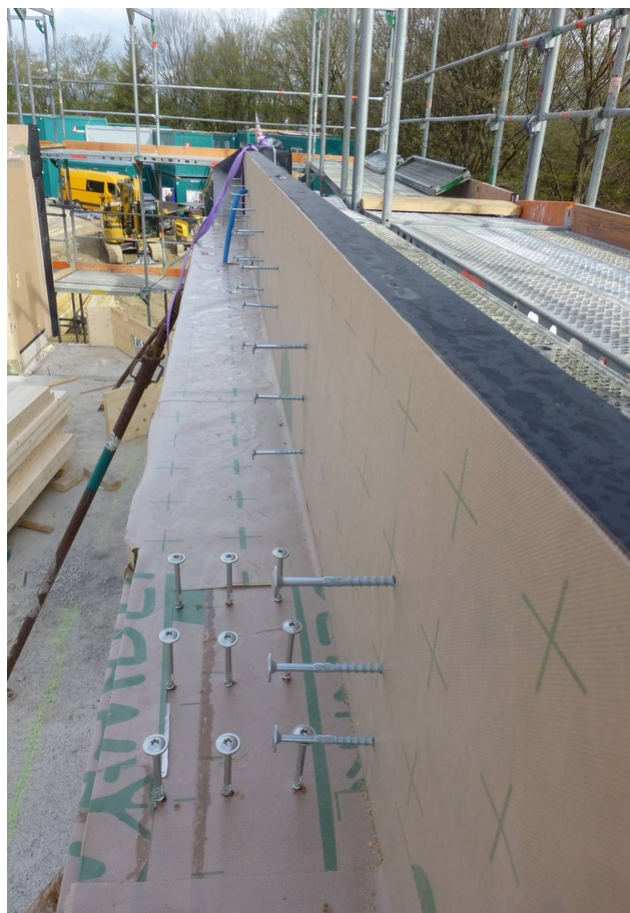
Stirnabschalung mit Stützenanschluss
