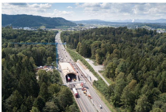
Luftbild während der Montage
