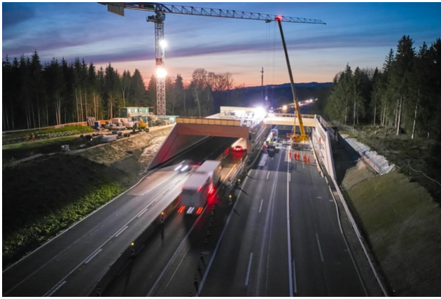
Montagearbeiten mit einspurigem Verkehr
