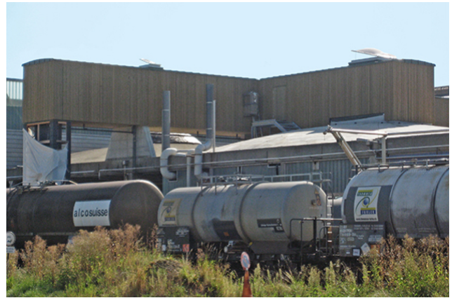
Befüllung vom Gleis
