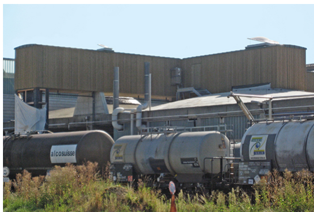
Befüllung vom Gleis
