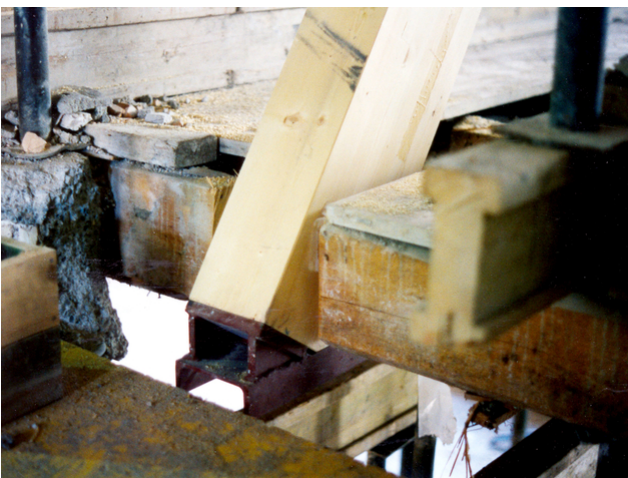
UNP-Träger, Endstütze Traverse
