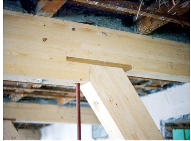
Querdruckbewehrung mit Hartholz
