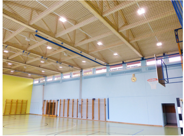
Innenansicht der Halle
