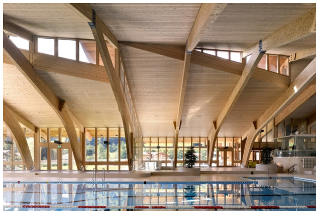
Zwischen den Bindern wurde das Akustiktäfer erneuert
