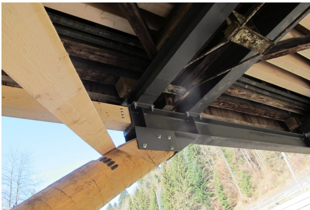
Anschluss der Eichenstämmе und Druckstäbe
