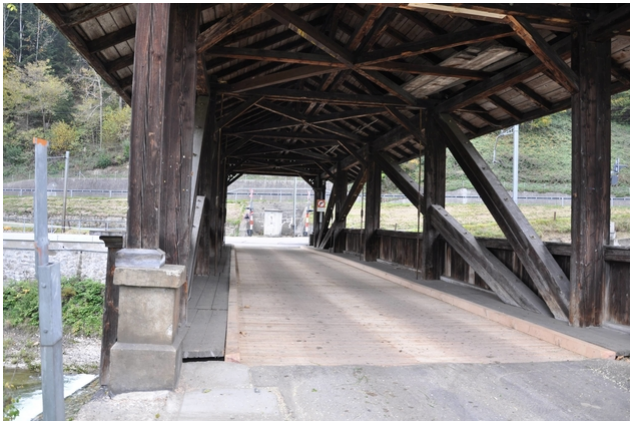
Neue Fahrbahn mit luftumspülten Eichenbrettern
