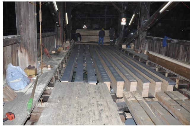
Montage neue Längsträger in der Nacht
