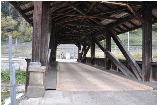
Neue Fahrbahn mit luftumspülten Eichenbrettern
