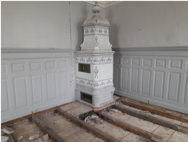
Geschossdecke vor Ertüchtigung
