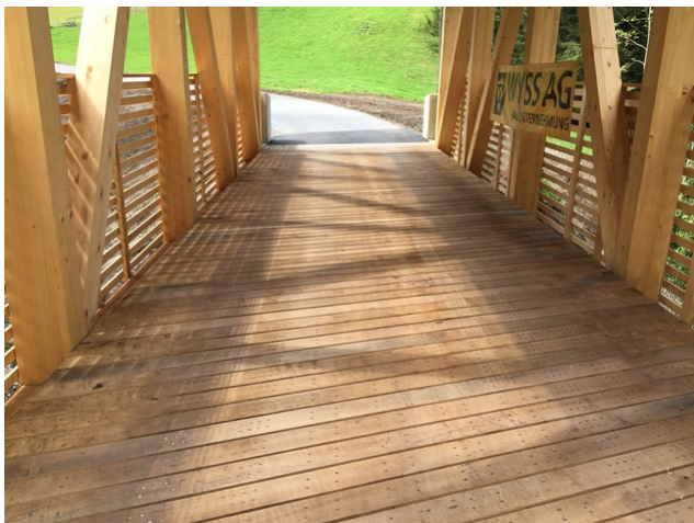
Alles Holz: der Bodenbelag der Brücke besteht aus Eichenbohlen
