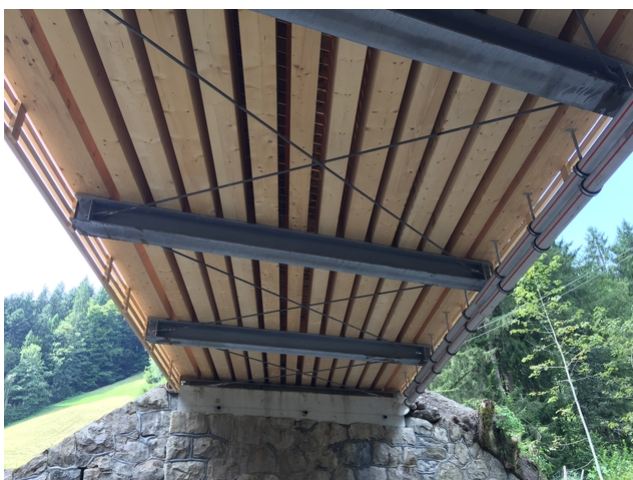
im Detail: das Tragwerk der neuen Holzbrücke
