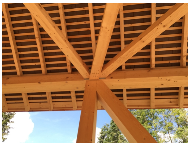
Halbholz-Knoten: hier laufen zwei Fachwerkstrukturen zusammen
