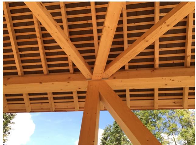
Halbholz-Knoten: hier laufen zwei Fachwerkstrukturen zusammen
