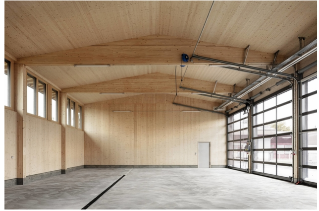
Grosse Tore befestigt an der Holzkonstruktion (Lucas Peter, Zürich)
