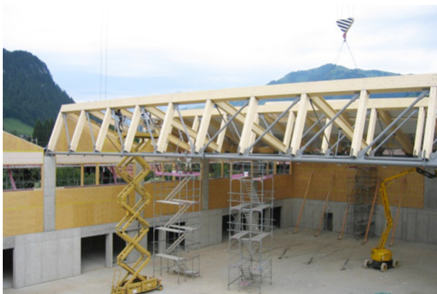
Montage von Fachwerkträgern
