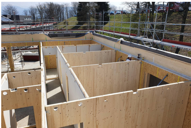
Innenwände in Brettspertholz
