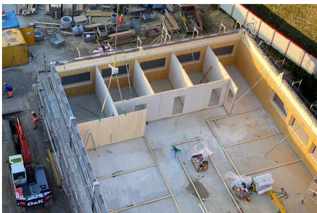
Montieren der Innenwände
