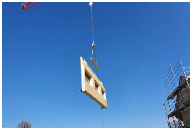
Aufrichten der Holzbauelemente
