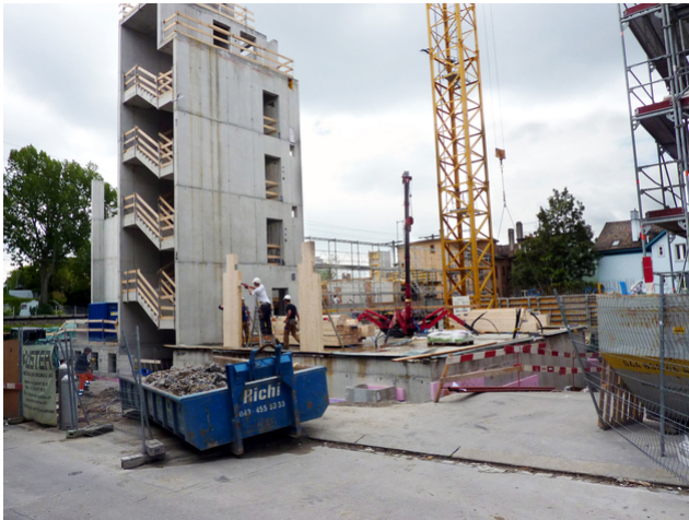
Start Stützenmontage EG
