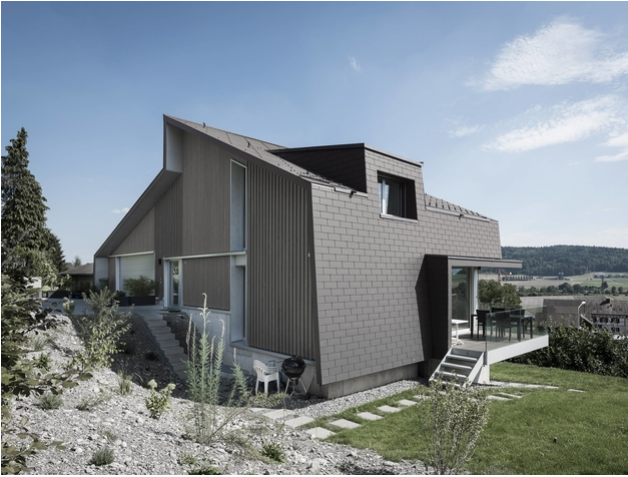
Spezielle Form: Das Dach reicht an einer Seite bis zum Boden
