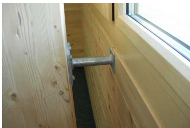
Detail Unterstützung - Fassade
