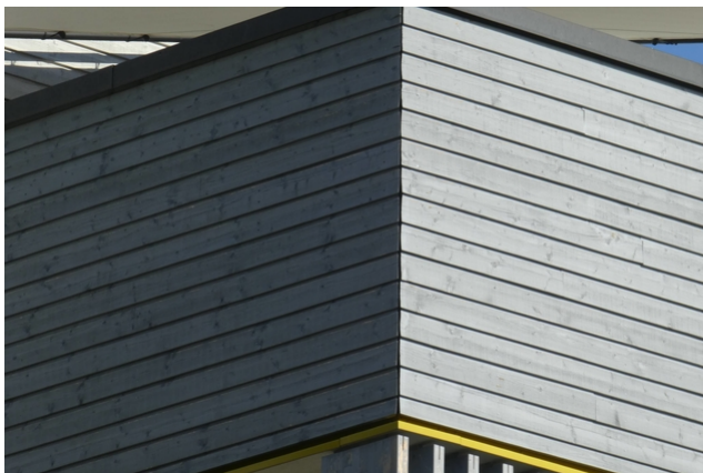
Fassade mit Patina nach 6 Jahren
