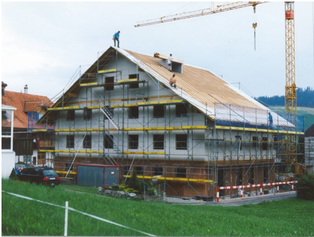
In der Bauphase
