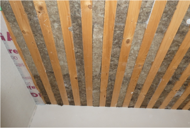
Deckendämmung im Scheunenumbau.
