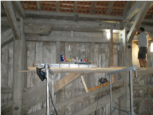
Strebensanierung der Brücke
