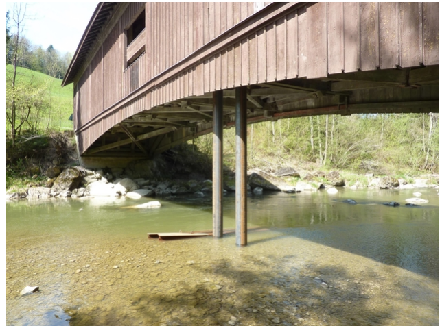
Provisorische Rammpfähle zur Stabilisierung
