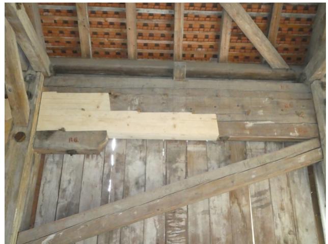
Bestehendes und saniertes Tragwerk
