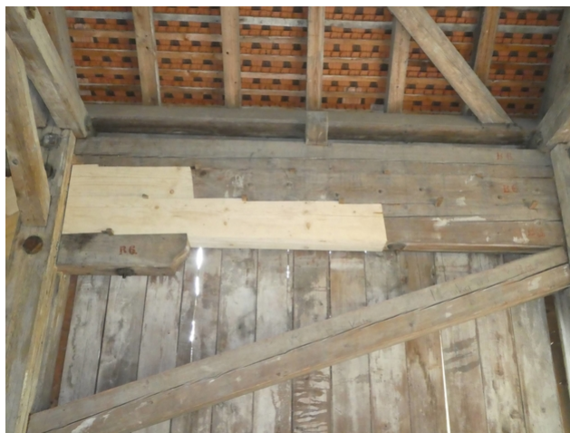
Bestehendes und saniertes Tragwerk
