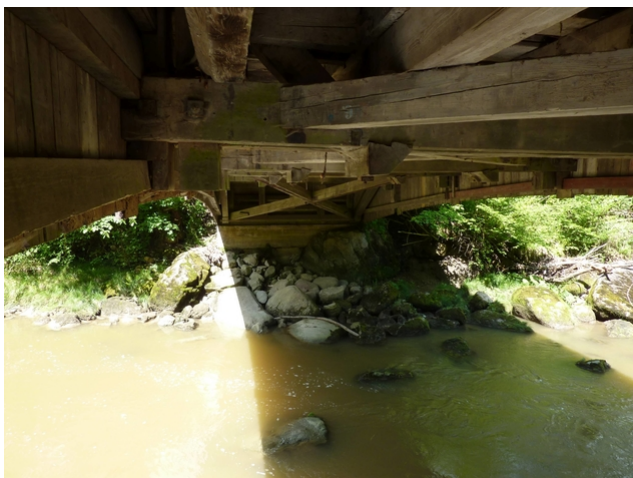
Untenansicht der Brücke
