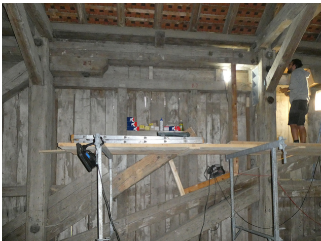
Strebensanierung der Brücke
