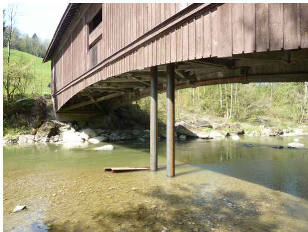
Provisorische Rammpfähle zur Stabilisierung
