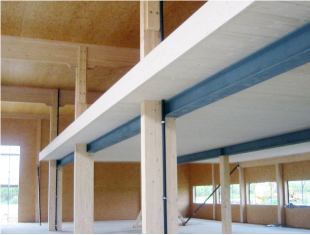
Galerie mit 1t Nutzlast pro m2
