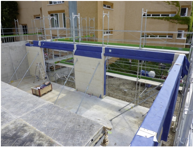
Im Bau: Zuerst wurden die Holzelemente eingebaut, dann die Decken betoniert
