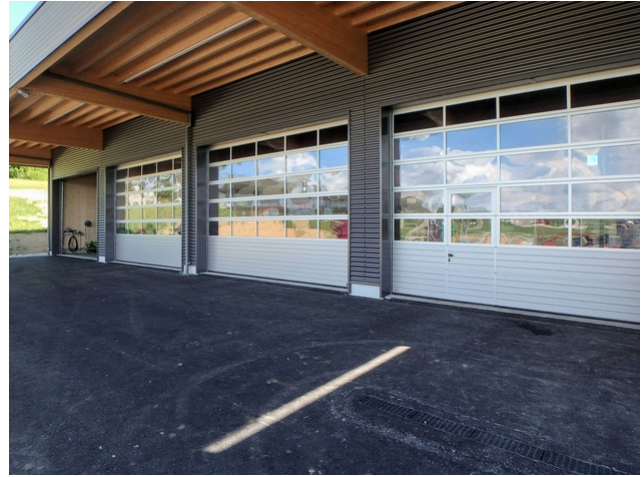
Das Vordach der neuen Garage ist stolze 5 Meter breit
