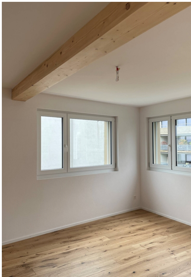
Unterzug aus Brettschichtholz
