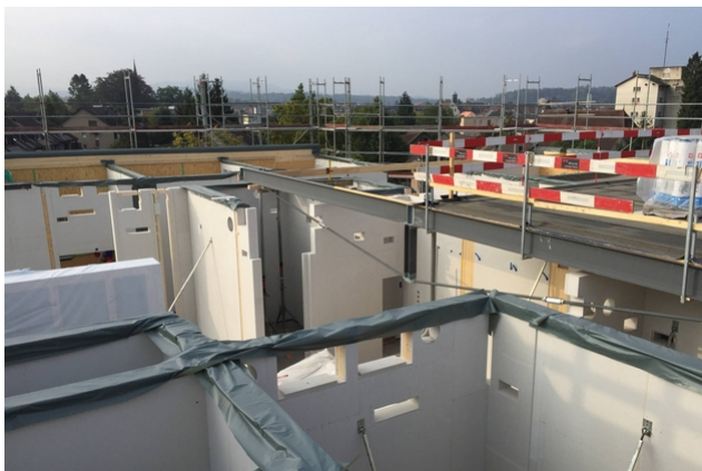
Einbau des unterspannten Unterzugs
