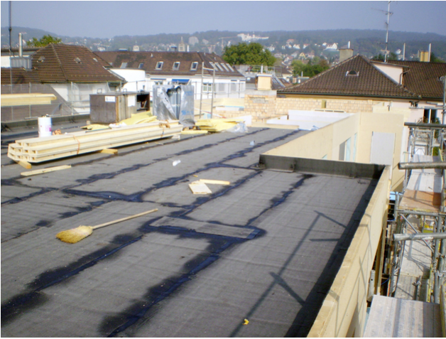
Aufstockung Erker Rohbau
