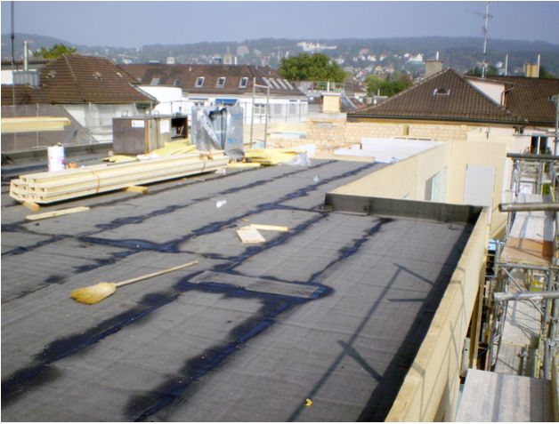
Aufstockung Erker Rohbau
