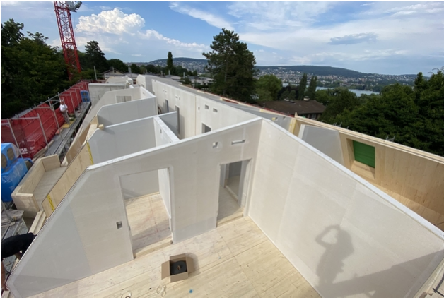
Ansicht direkt in den Elementbau Aufstockung
