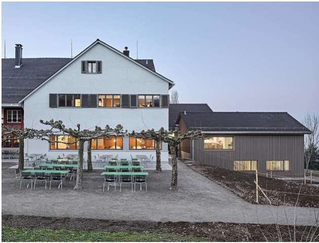
Rechtes Bild: Das von Timbatec geplante neue Holzgebäude
