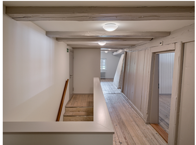
Zwischen die bestehenden Balken wurden neue Brandschutzverkleidungen eingefügt
