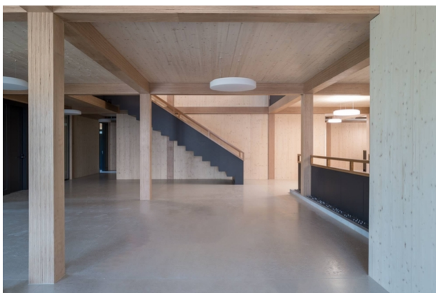
Vue intérieure avec supports en hêtre
