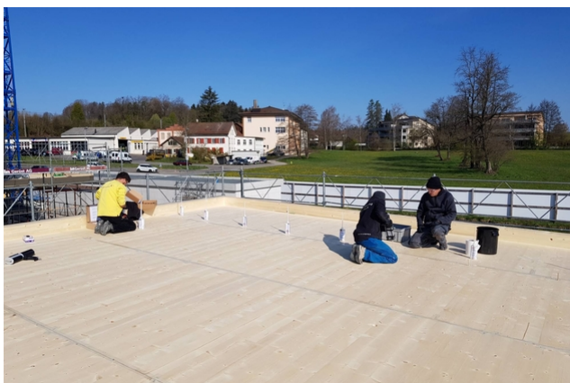
TS3 lors du scellement TS3 de l'avant-toit
