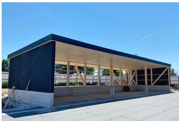
Couverture de la maison des conteneurs
