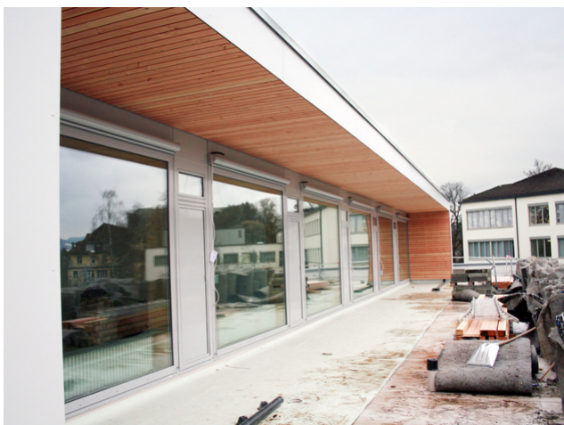
Vue de la façade de la surélévation côté nord
