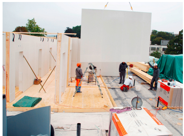
Déplacement de cloisons Rehaussement
