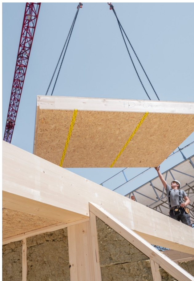
Mise en place d'éléments de plancher
