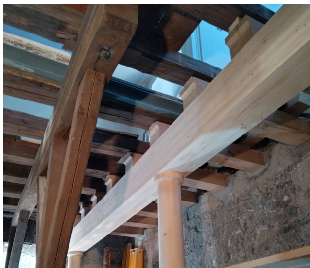
Mesures d'assainissement dans la cave à vin
