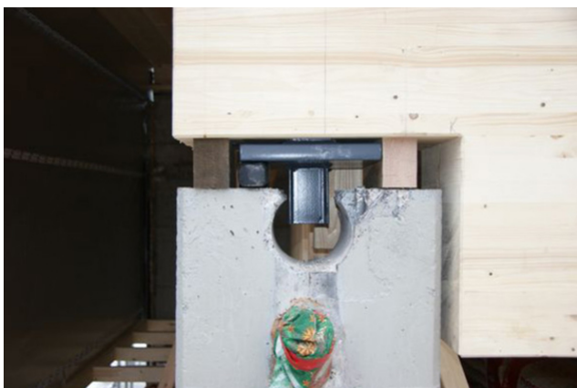
Soutien avant la coulée
