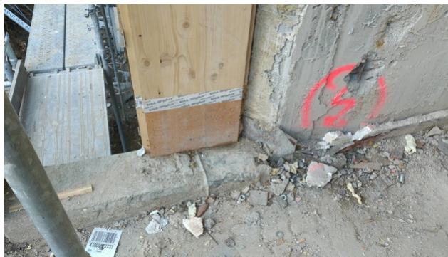
Raccordement de la structure en bois aux éléments en béton existants
