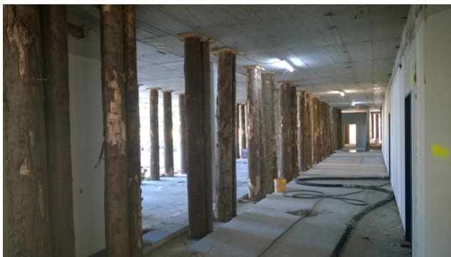
Soutien provisoire avec des troncs d'arbres
