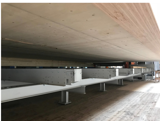
Vue d'en bas de la construction de la plateforme
