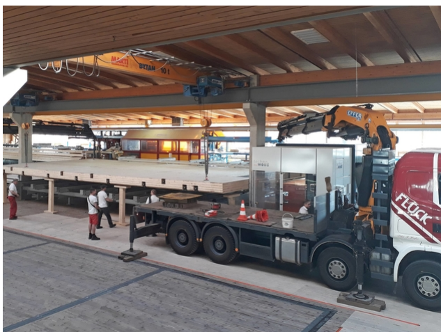
La plate-forme est hissée au bon endroit et installée dans le hall
