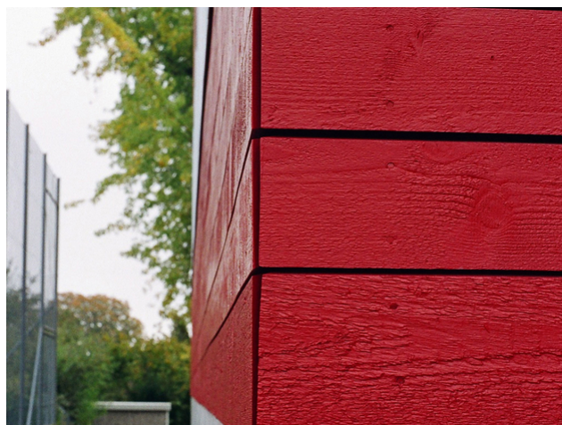
Coffrage zone d'angle
