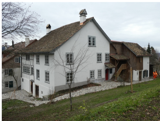
Vue de l'arrière de la maison
