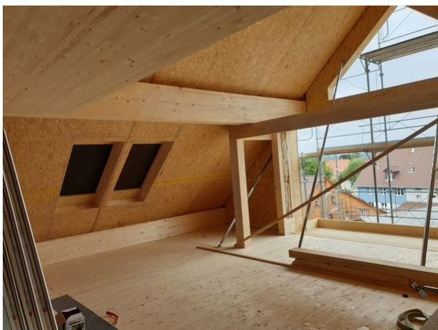
Phase de construction du grenier
