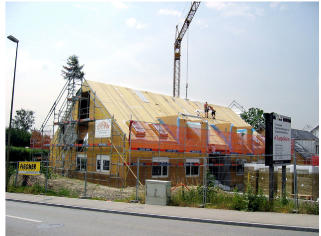
Préparation de l'isolation du toit
