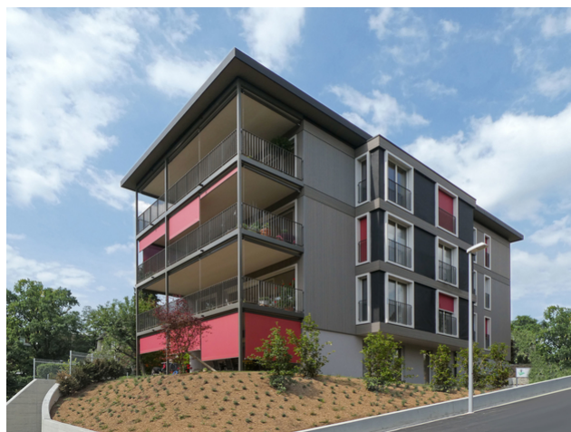
D'autres panneaux solaires seront installés sur les encorbellements ultérieurement.
