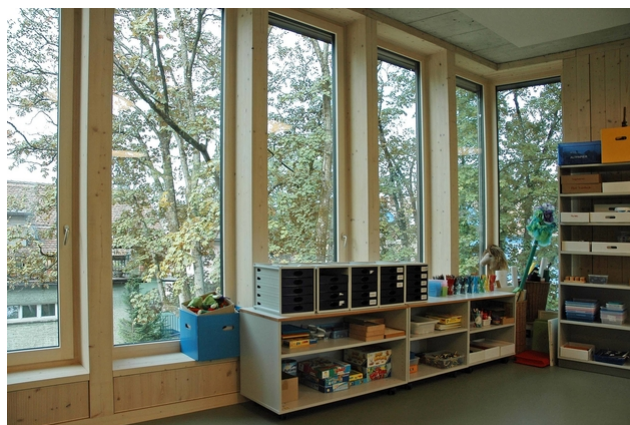
La crèche est en service depuis 2015
