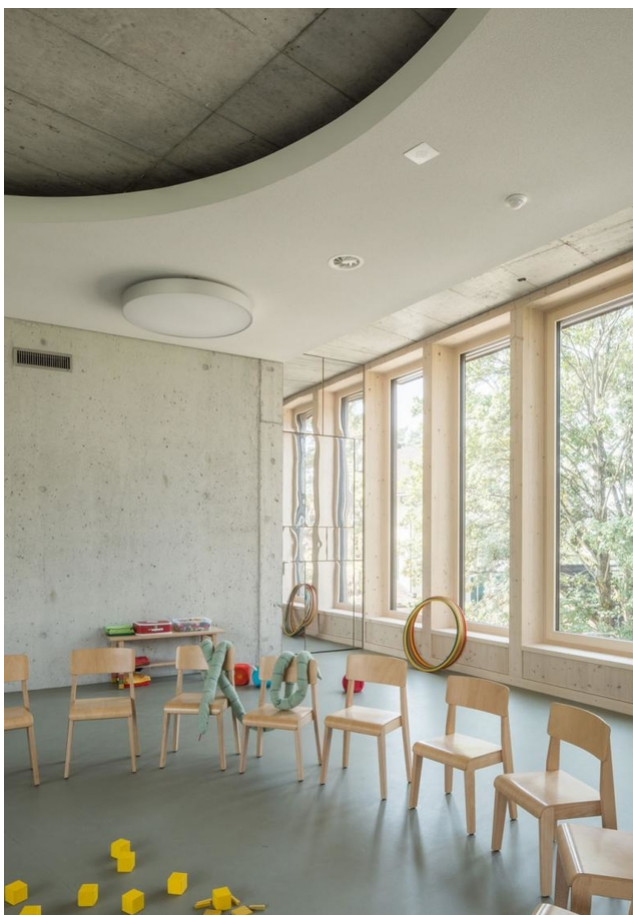
Vue intérieure : façade en bois. Au-dessus se trouve le plafond en béton
