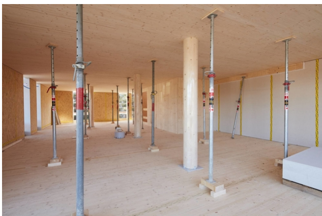
Pendant le durcissement de la résine de coulée, les dalles doivent être étayées.
