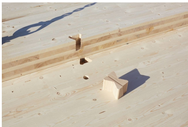
Das Gebäude während der Entstehung
