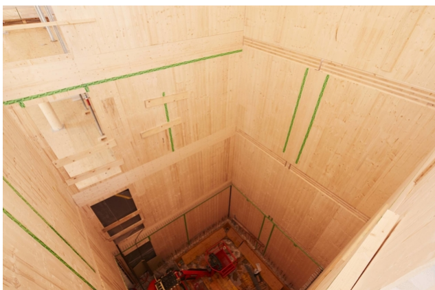
Le noyau de la cage d'escalier est en place. Le béton liquide est coulé ultérieurement
