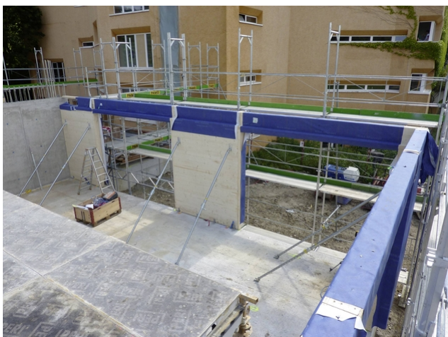
En construction : les éléments en bois ont d'abord été installés, puis les plafonds ont été bétonnés.
